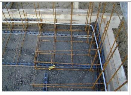
Image 1 : Un expert doit contrôler la bonne exécution des installations de mise à la terre avant le remblayage et la terre de fondation avant le bétonnage ; alternativement, d'entente avec l'autorité de prévention des incendies ou l'organe de contrôle, il convient de documenter la bonne exécution par des photographies.
